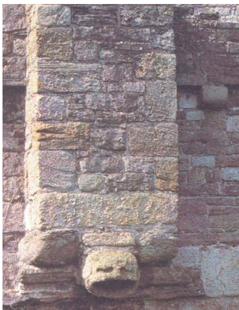
Зовнішній вертикальний стовп, вбудований в стіну замку Бомаріс, побудованому у період з 1295 до 1330 р. Едвардом I на узбережжі острова Англіс (Північний Уельс). Через нього витікали відходи з туалету
